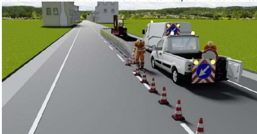
Figura 10 – Installazione segnaletica cantiere fisso su strada
