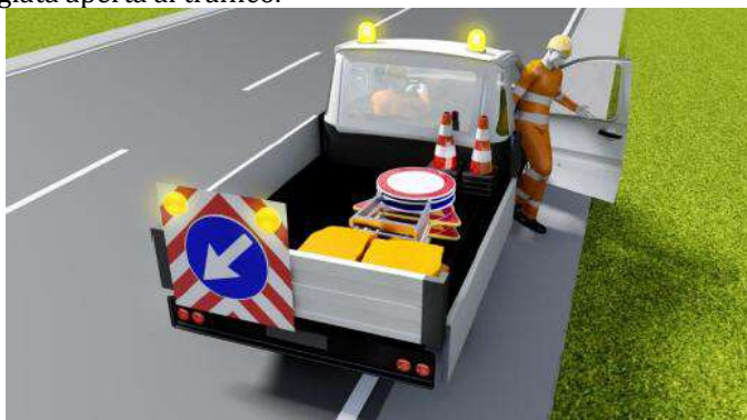
Figura 3 – Uscita operatore da automezzo per posa segnaletica
