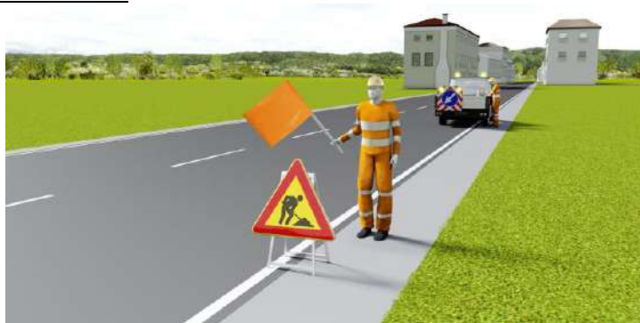
Figura 6 – Sbandieratore prima di posa segnaletica
