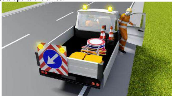
Figura 7 – Uscita operatore da automezzo per posa segnaletica
