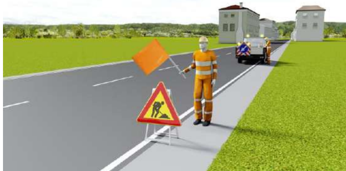
Figura 2 – Sbandieratore prima di posa segnaletica
