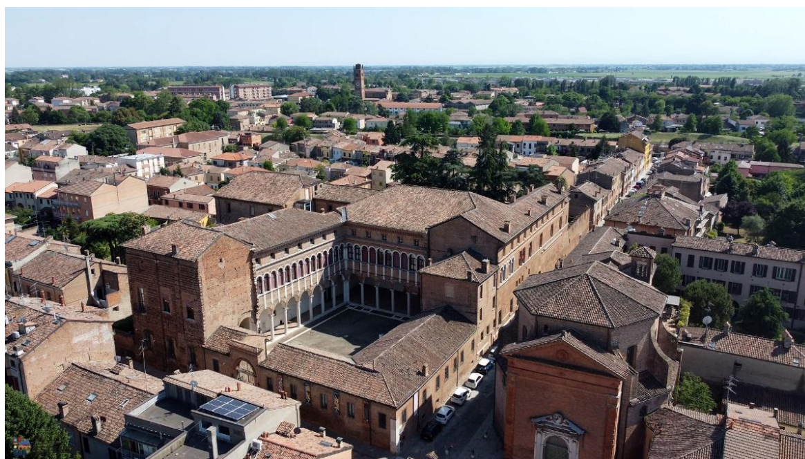
Figura 8 – Veduta di Palazzo Costabili, Ferrara (Foto: progetto Ducato Estense)
